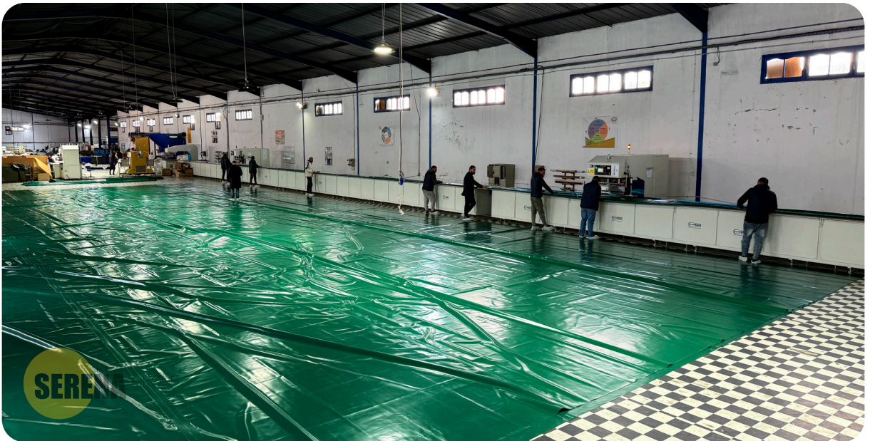
Fabrication d'une citerne de 1000 m 3
